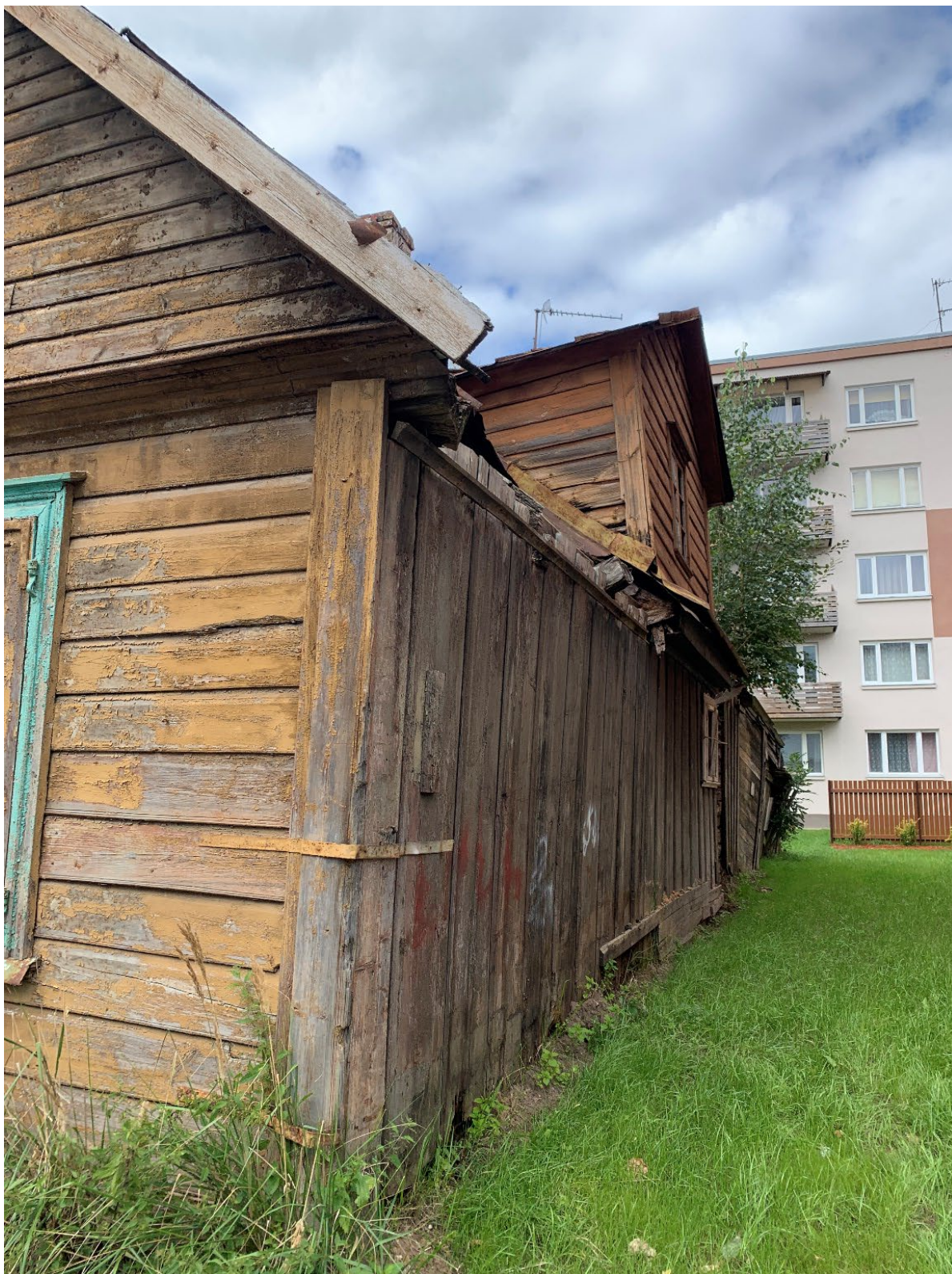
Foto 8. Uus tn 16//18 lagunenud vana elamu Uuelt tänavalt vaadatuna, paremale jääb Uus tn 14 kortermaja. Hoone on vintskapi osa juurest tugevalt lagunenud ja kaldu vajunud, puudub enamusest katusest.
